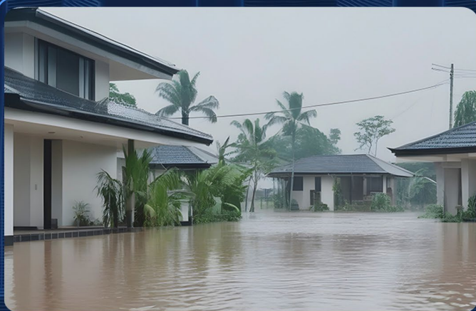
Niveau de l'inondation
