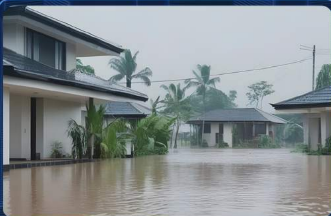
Control de Inundaciones
